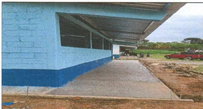
Foto 3: CULMINACION DE SUSTITUCION DE VENTANAS DE AULAS
